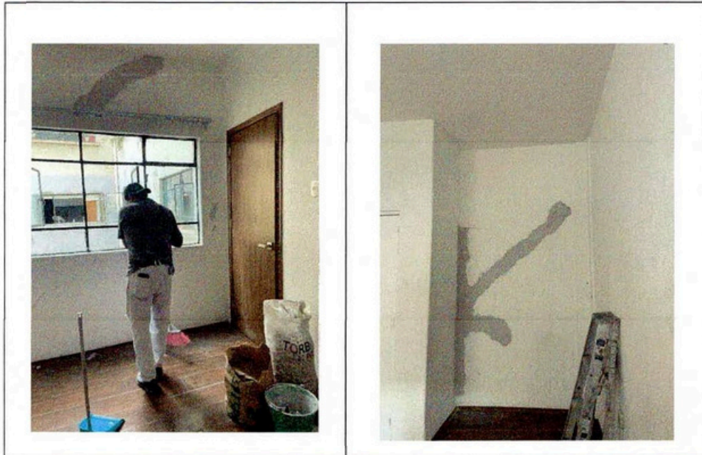
Imagen 1. Reparación de departamento, Sinaloa 142
