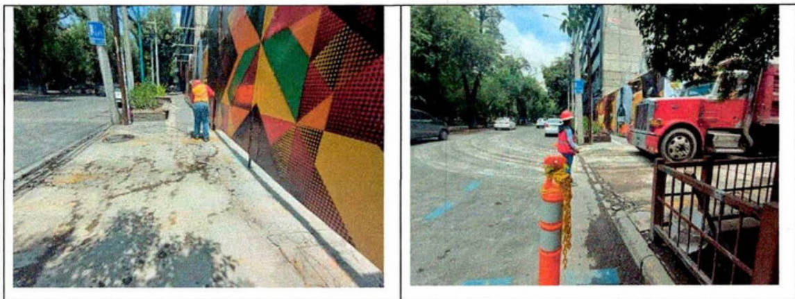
Imagen 5. Evidencia fotográfica de actividades en sitio
