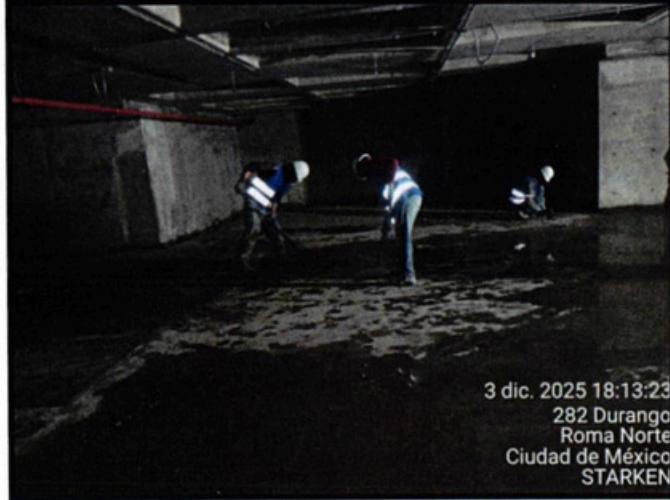
Imagen 4-7: Limpieza dentro de la obra utilizando agua para minimizar el levantamiento de polvo.
