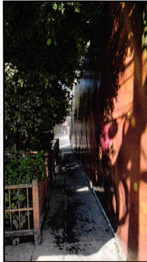
Imagen 1-3: Limpieza al exterior de la obra utilizando agua para minimizar el levantamiento de polvo.
