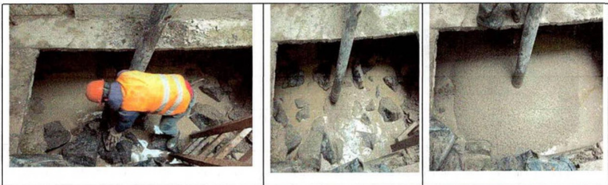
Imagen 3. Relleno del socavón
