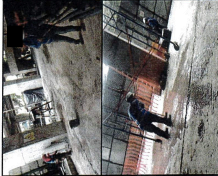
Imagen 3-7: Limpieza dentro de la obra utilizando agua para minimizar el levantamiento de polvo.
